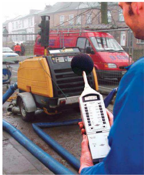
**Bezvýkopové sanace kanalizací** kladou vysoké nároky na přečerpávání kalů kolem sanovaného úseku potrubí. SPP<sup>autoprime</sup> je nezávislý na cizím zdroji energie. Celokapotované provedení zajišťuje dokonalé tlumení hluku. To dovoluje provozovat čerpadlo ve městě i v nočních hodinách.
