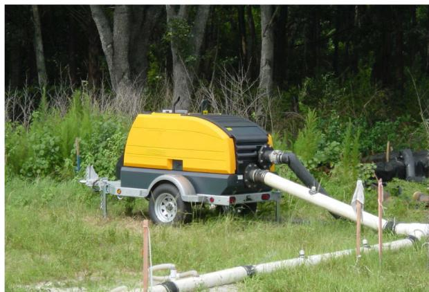
**Odčerpávání vody ze stavebních jam – systém Wellpoint:** sání čerpadla tvoří kolektory napojené na čerpací jehly, které spolehlivě sníží hladinu spodní vody v celé délce výkopu.
