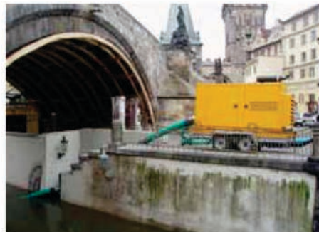
Nasazení čerpadla QI250 při odčerpávání povodňových vod na Čertovce v r. 2009.
